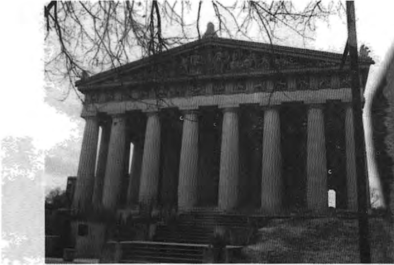
إعادة بناء معبد البارثينون في أثينا كما كان عليه في الأصل في القرن الخامس ق.م. حيث أشاده بريقليس الشهير على يد المعمار «ايكتينوس» والنحات الشهير «فيدياس».
